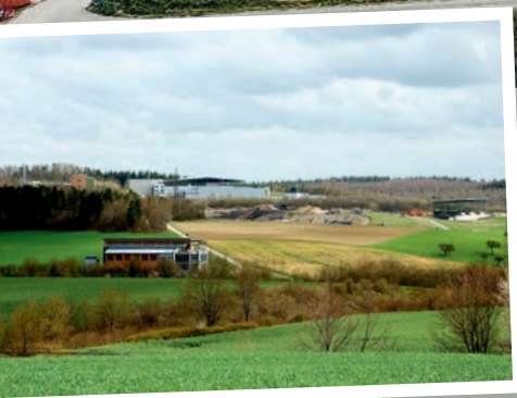
Derzeitiger Zustand der Deponie Blick aus Nordwesten
